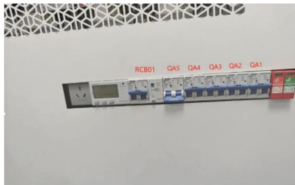
Abbildung 62 – Schalter für die Zusatzmodule
