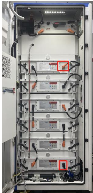
Abbildung 56 – Lage der Plus- und Minusstecker des Batterieclusters
