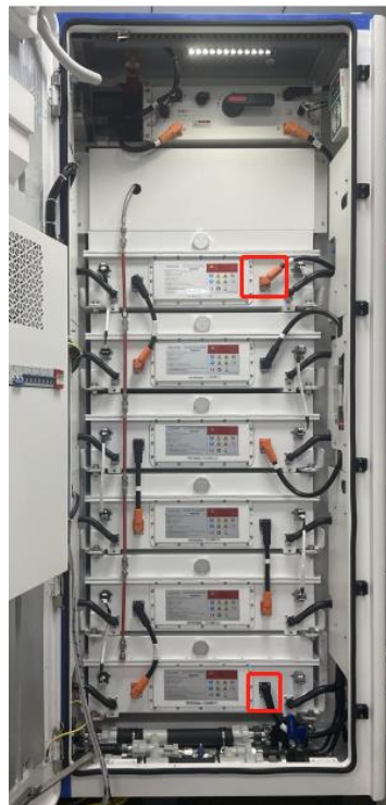
Abbildung 61 – Lage der Plus- und Minusstecker des Batterieclusters
