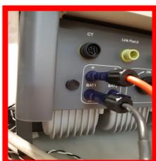
Settare i canali batteria nell'inverter in base alla configurazione delle torri batterie.
