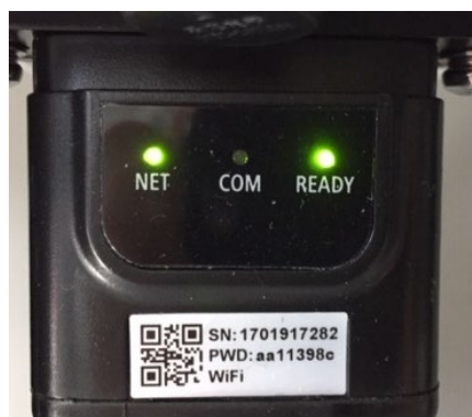
Figura 79 - Stato di comunicazione irregolare tra inverter e adattatore
