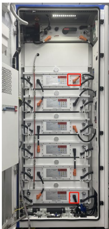
Figura 61 – Posizioni delle spine positiva e negativa del cluster della batteria
