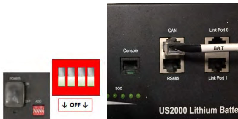
Figura 19- Collegamento del cavo di comunicazione alla batteria Pylontech
