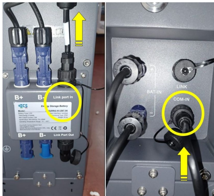
Figura 132 - Connessioni comunicazione: BDU e primo modulo batteria
