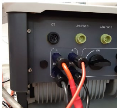
Figura 167 - Connessione potenza DC lato inverter con due ingressi batteria popolati
