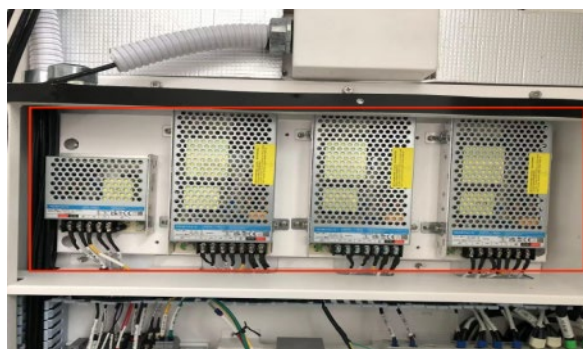
Figura 35 - alimentador eléctrico de conmutación
