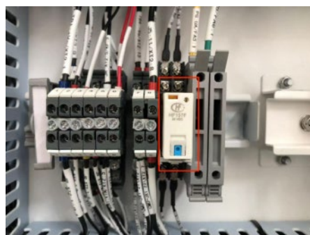
Figura 32 – botón de prueba del ventilador de descarga
