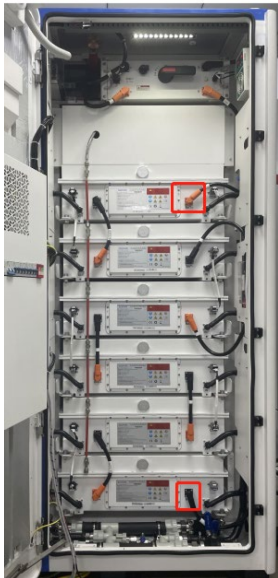
Figure 2 - Position des fiches positive et négative du cluster de la batterie
