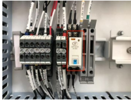
Figure 32 – Bouton d’essai du ventilateur d’extraction
