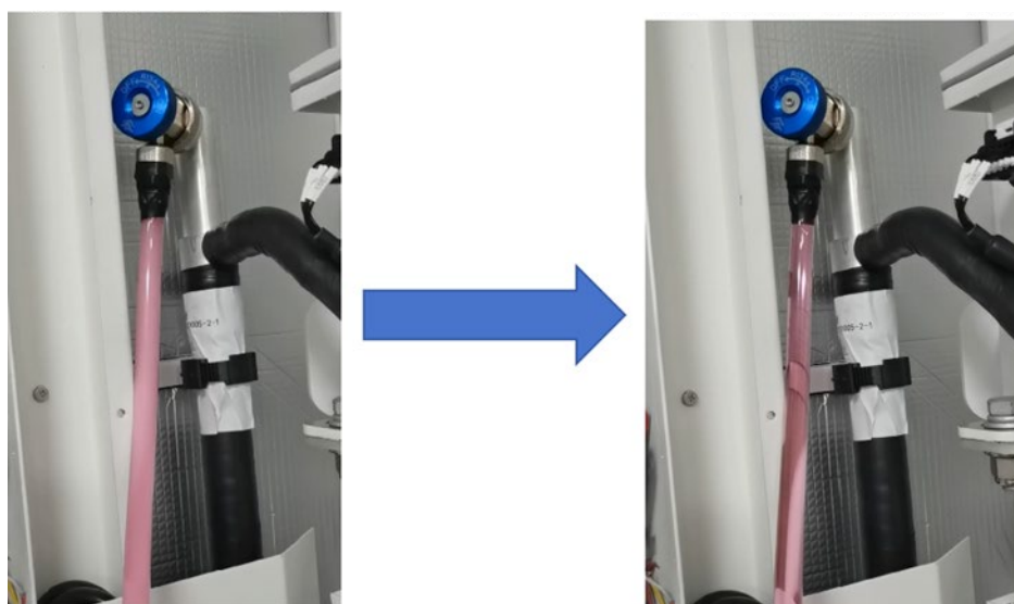
figure 16 – Achèvement du dégazage
