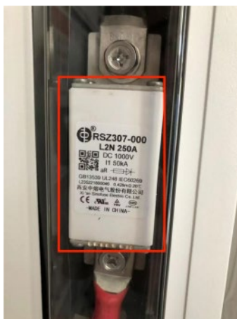
Figura 18 – bezpiecznik klastra zestawu baterii
