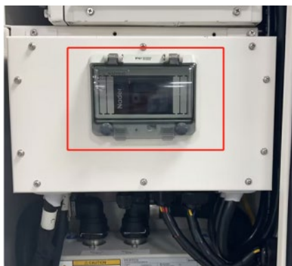
Rysunek 26 – przełącznik obwodowy CA
