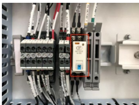
Rysunek 32 – Przycisk testu wentylatora wyciągowego
