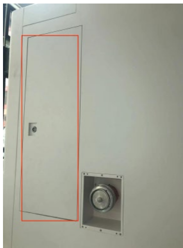
Рисунок 43 – Двері доступу до балона пожежогасіння
