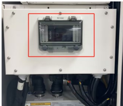
Рисунок 26 – Автоматичний вимикач ЗС
