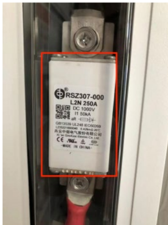
Рисунок 18 – запобіжник кластера акумуляторної батареї
