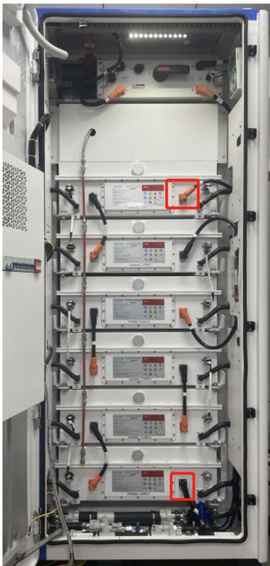
Рисунок 2 – Розташування позитивного і негативного роз'єму кластера акумуляторної батареї
