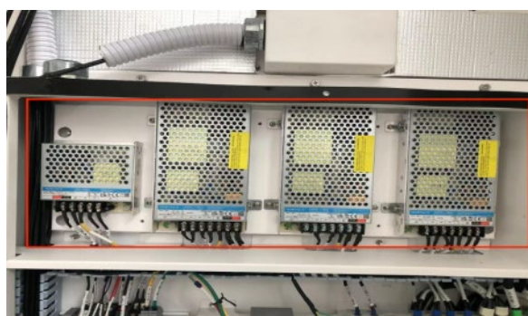
Рисунок 35 – імпульсний блок живлення
