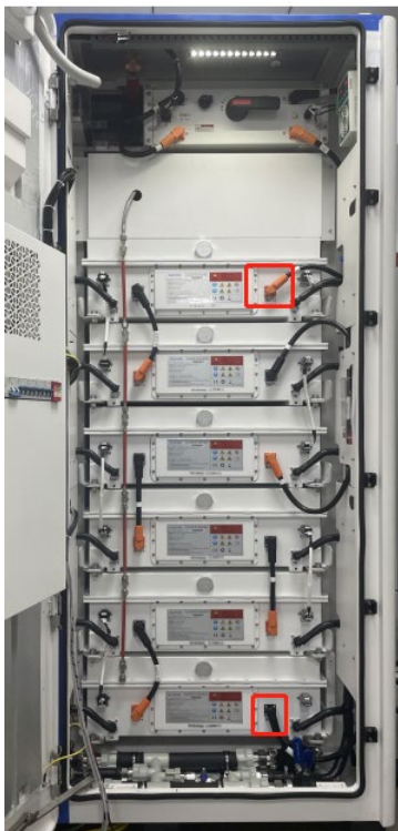
Figura 56 – Posiciones de las clavijas positiva y negativa del clúster de la batería
