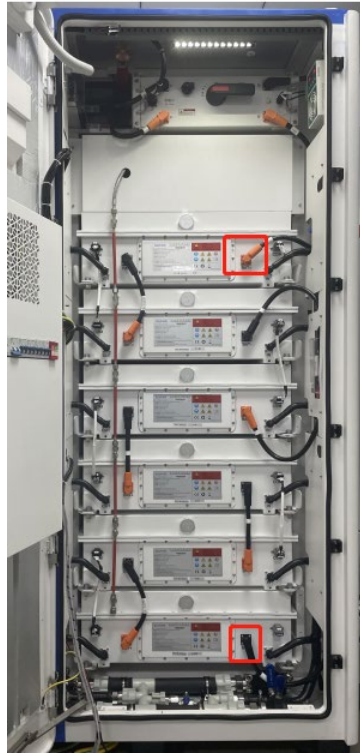
Figure 56 – Position des fiches positive et négative du cluster de la batterie
