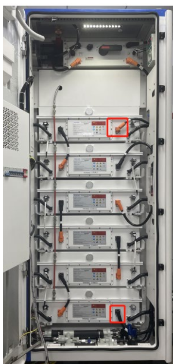
Figure 61 – Position des fiches positive et négative du cluster de la batterie
