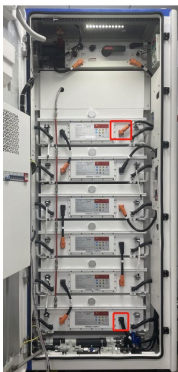
Rysunek 61 – Położenie wtyczki dodatniej i ujemnej zestawu baterii
