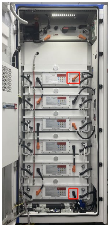
Rysunek 56 – Położenie wtyczki dodatniej i ujemnej zestawu baterii
