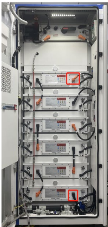
Рисунок 56 – Положения позитивного і негативного штекера кластера аккумуляторної батареї
