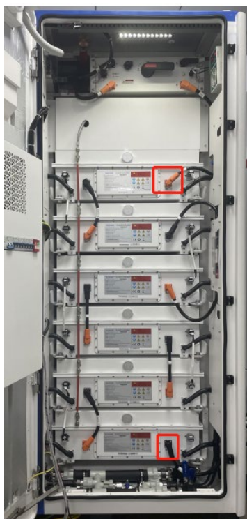
Рисунок 61 – Положення позитивного і негативного штекера кластера акумуляторної батареї
