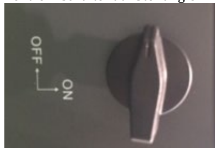
Abbildung 110 - Solaranlagentrennschalter
