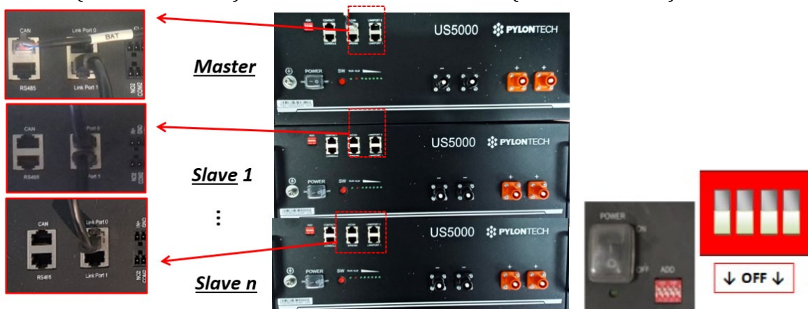
Abbildung 21 - Anschließen des Kommunikationskabels zwischen drei Pylontech-Batterien
