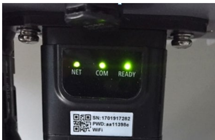
Figure 143 – État final des led
