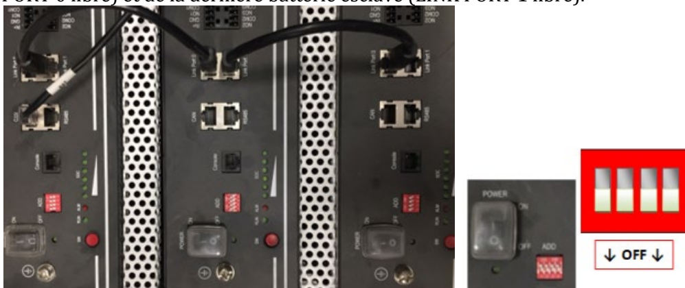
Figure 16 - Connexion du câble de communication entre trois batteries Pylontech
