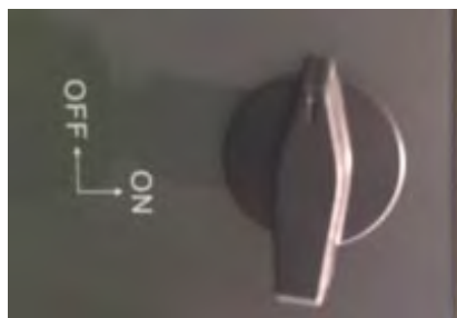
Rysunek 110 - Wyłącznik fotowoltaiczny
