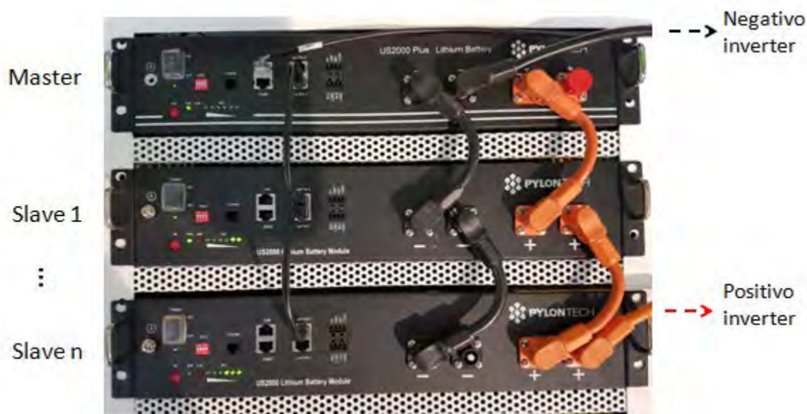
Rysunek 17 - Podłączenie równoległe trzech baterii Pylontech
