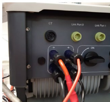
Abbildung 167 - Wechselrichter-Stromanschluss DC mit zwei Eingängen Batterie belegt
