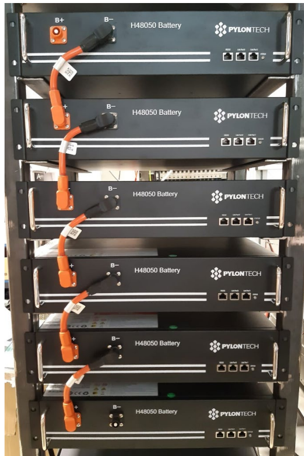
Abbildung 42 - Stromverkabelung zwischen Batteriemodulen
