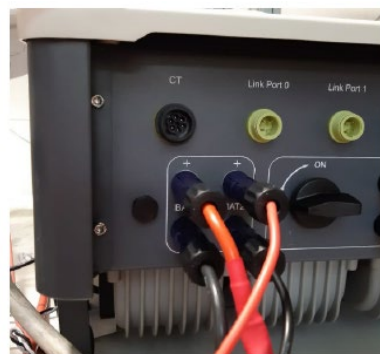
Abbildung 183 - Wechselrichter-Stromanschluss DC mit doppeltem Eingang Batterie bestückt
