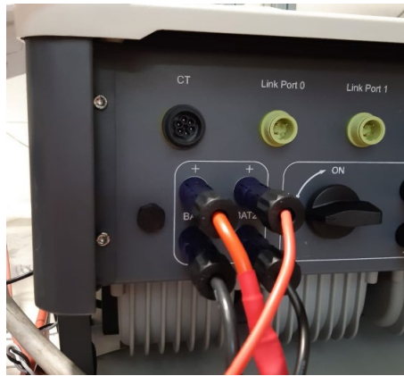
Abbildung 56 - DC-Stromanschluss Inverterseite mit zwei belegten Batterieeingängen
