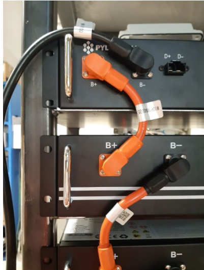
Abbildung 44 - Stromanschluss (positiv) zwischen BMS und erstem Batteriemodul
