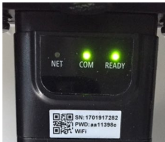
Abbildung 245 – Unregelmäßiger Kommunikationsstatus zwischen Platine und Remote Server
