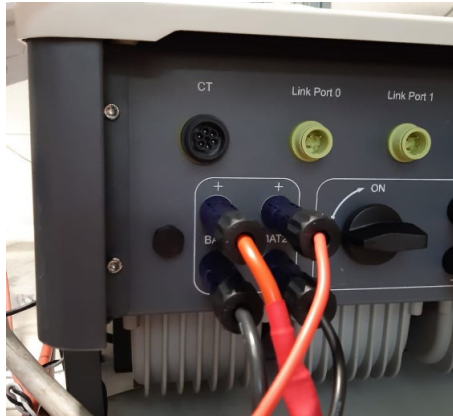
Abbildung 64 - DC-Stromanschluss Inverterseite mit zwei belegten Batterieeingängen
