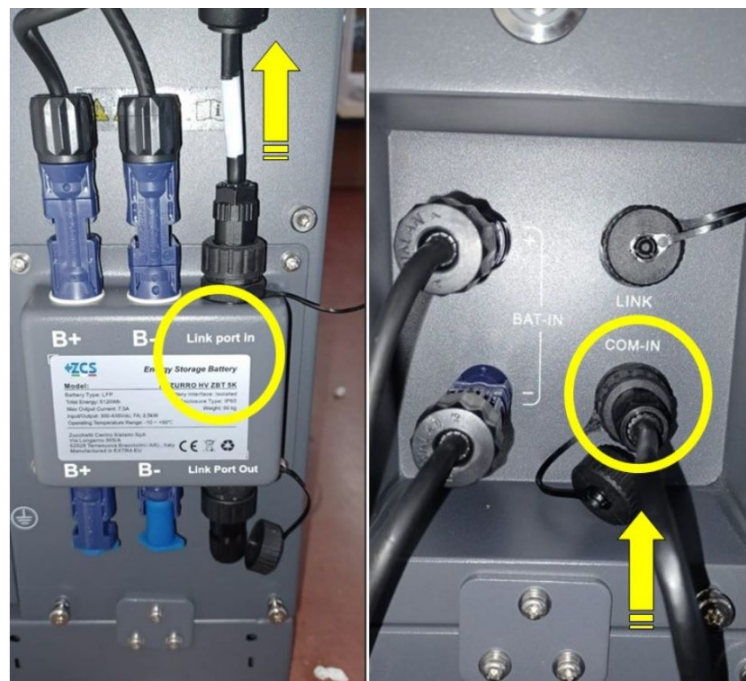
Abbildung 132 - Kommunikationsanschlüsse: BDU und erstes Batteriemodul
