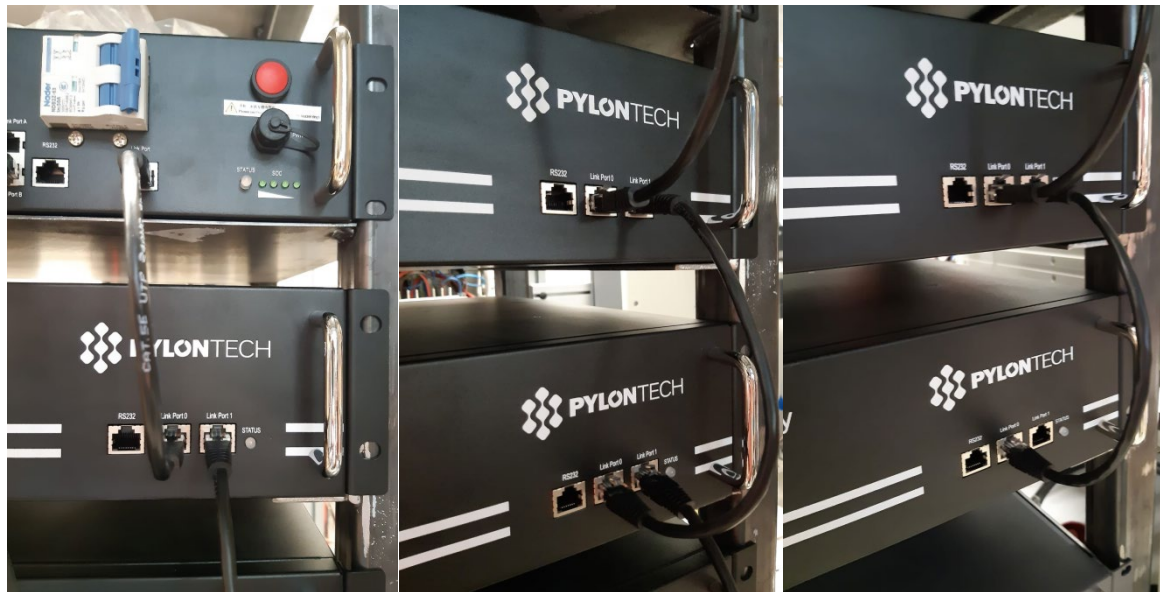
Figura 31 - Conexiones de comunicación: BMS y primer módulo de batería (izquierda), conexión entre módulos de batería (al centro), conexión entre módulos penúltimo y último de la serie (derecha)
