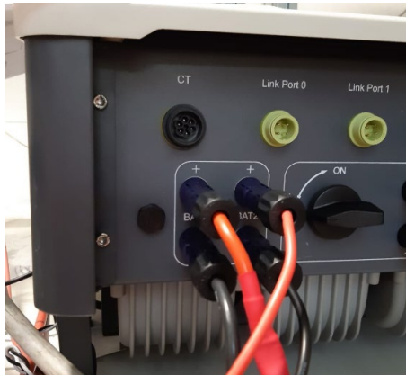
Figura 111 - Conexión de potencia CC lado inversor con dos entradas de batería pobladas
