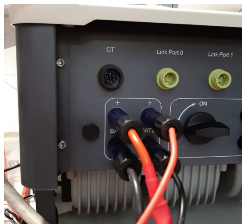
Figura 101 - Conexión de potencia CC lado inversor con una doble entrada de baterías poblada
