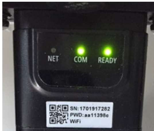
Figura 245 – Estado de comunicación irregular entre tarjeta y servidor remoto
