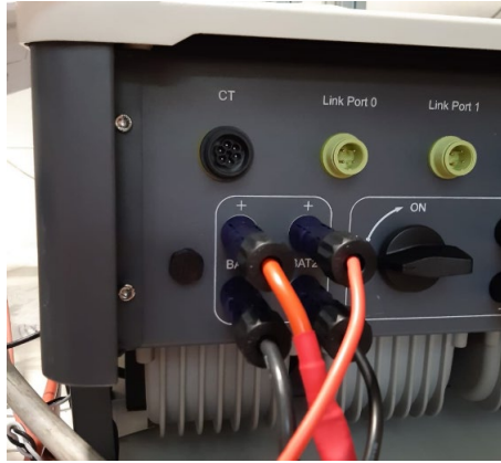
Figura 64 - Conexión de potencia CC lado inversor con dos entradas de batería pobladas
