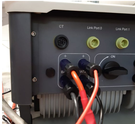
Figura 87 - Conexión de potencia CC lado inversor con dos entradas de batería pobladas
