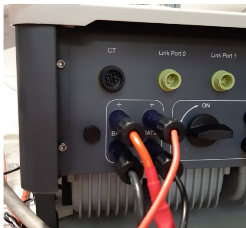
Figura 78 - Conexión de potencia CC lado inversor con una doble entrada de baterías poblada
