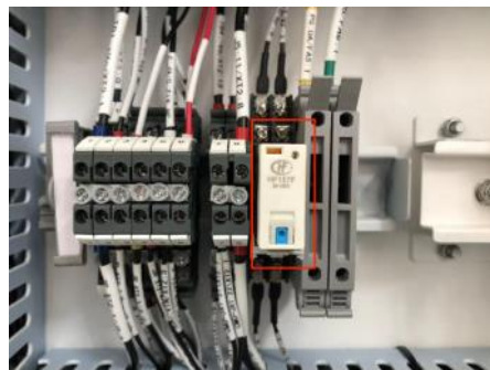
Abbildung 32 – Kühllüfter-Testschalter
