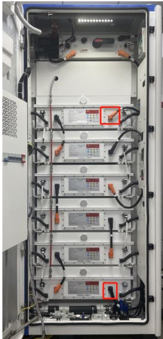
Abbildung 2 – Position der Plus- und Minusstecker des Batterieclusters
